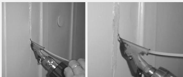
8 - Pour éteindre la machine à souder, placez le bouton rouge (C) du thermostat sur la valeur 0, désactivez le bouton résistances en plaçant l'interrupteur noir (B) sur OFF, éteignez la machine à souder en plaçant l'interrupteur gris (A) pour OFF et retirez la fiche secteur de la prise de courant 230V.
